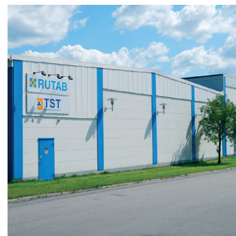
Entrepôt et usine de production à Nässjö en Suède
